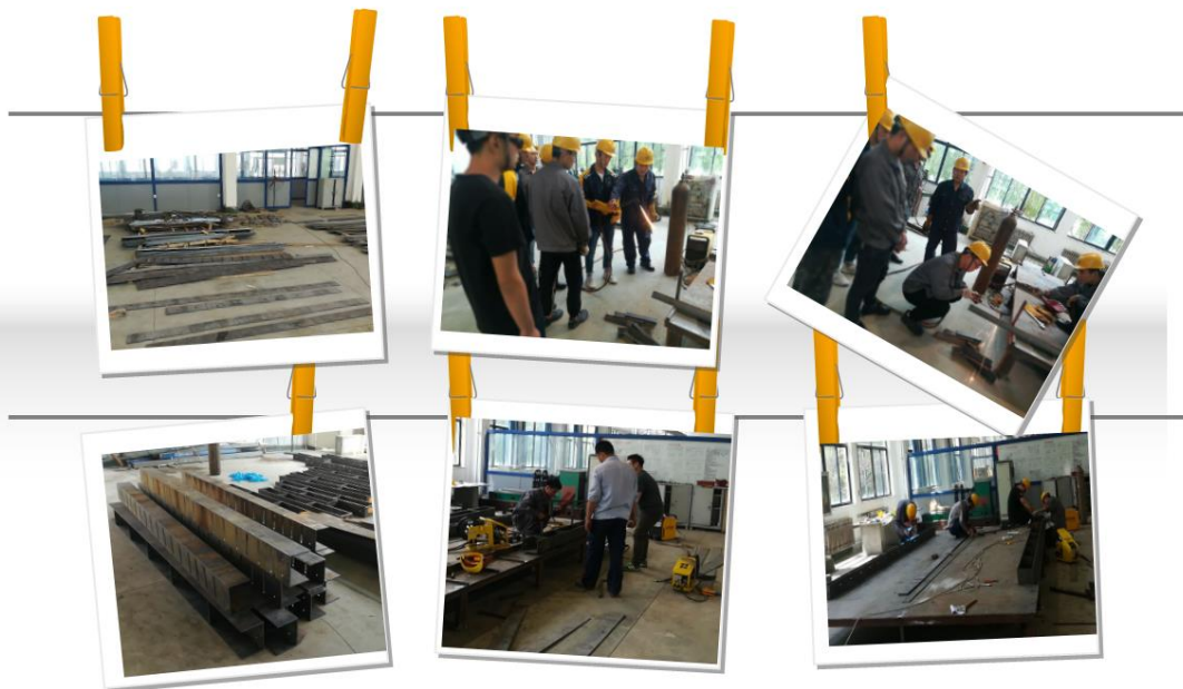
图5 装配式建筑模板的焊接
