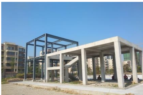
装配式建筑工法实训区
