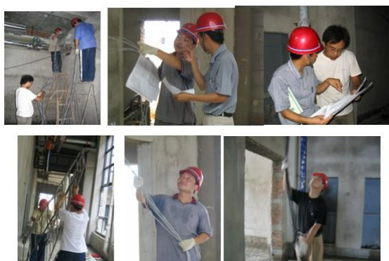
专业教师带领学生进行网络工程施工
