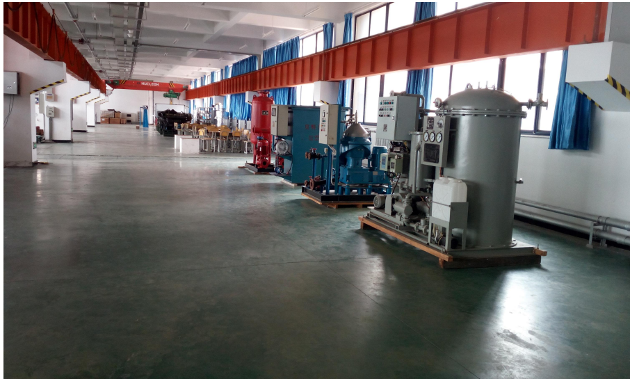
图 2 船舶辅机安装与维修实训区
